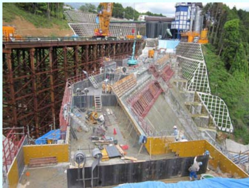
(右岸側から堤体を望む)
