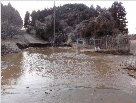
(地震発生後の送水管からの漏水の状況)
